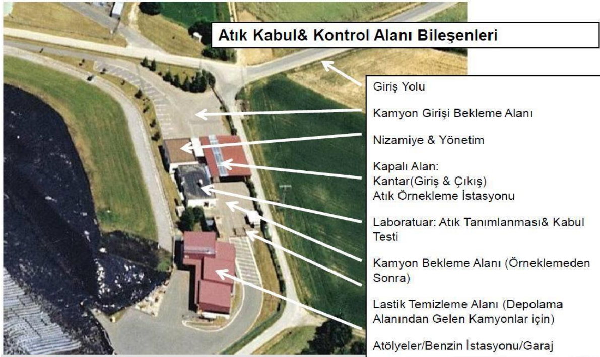
Şekil 10-4 Örnek depolama tesisi
