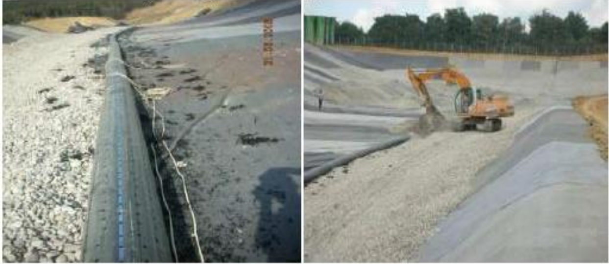
Şekil 10-3 Sızıntı suyu drenaj borusu yerleştirilmesi
