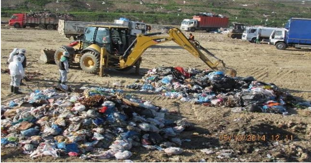
Fotoğraf 6- 1 Belirlenen bölgelerden gelen atığın boşaltılması ve kepçe ile karıştırılması
