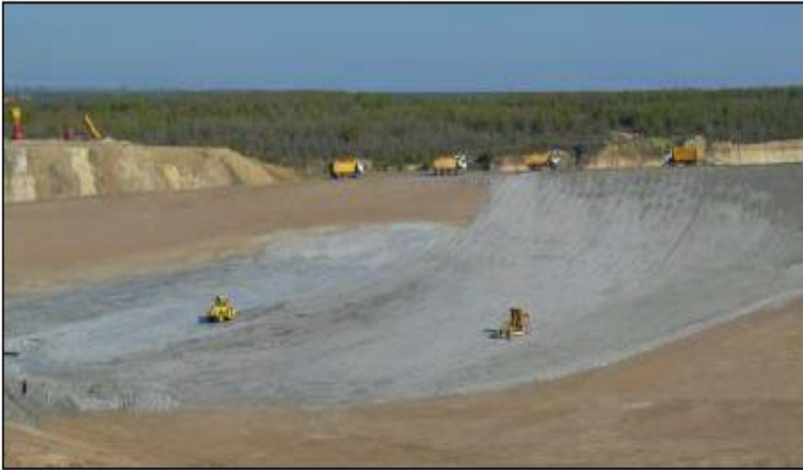
Şekil 10-2 Kil serimi ve sıkıştırılması
